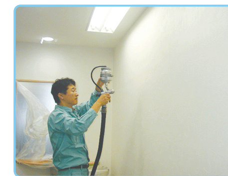
エアブラシで住宅などの壁と天井に噴霧します
